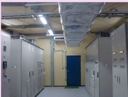
ダクト施工状況
