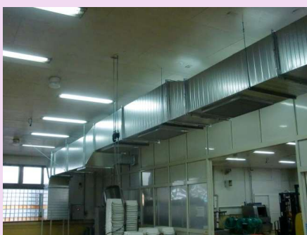
外気導入ダクト設置状況
