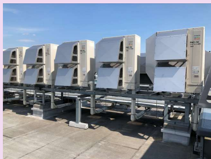
室外機設置状況
