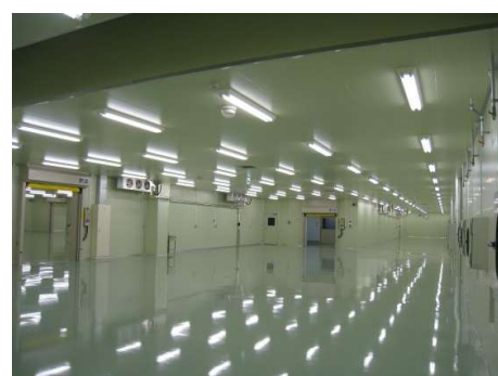
断熱パネル工事
