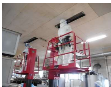
低圧電気設備工事
