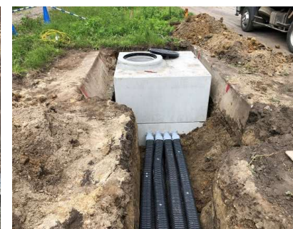
送電線ハンドホール設置工事
