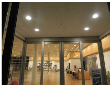
店舗エントランスの照明更新事例
