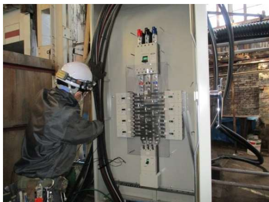
低圧動力盤の更新作業
