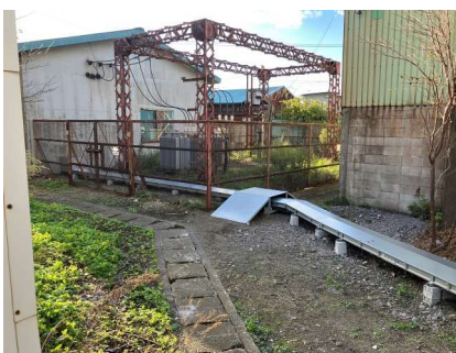
送電線ルート切替工事
