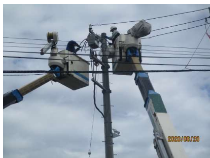
受電用開閉器(PAS)交換工事
