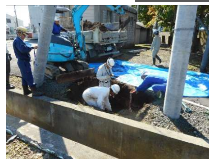
接地極改修工事
