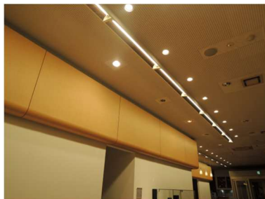
壁面間接照明の更新事例
