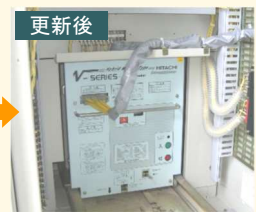
高圧受変電盤 真空遮断器のリニューアル例
