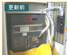
高圧受変電盤 真空遮断器のリニューアル例
