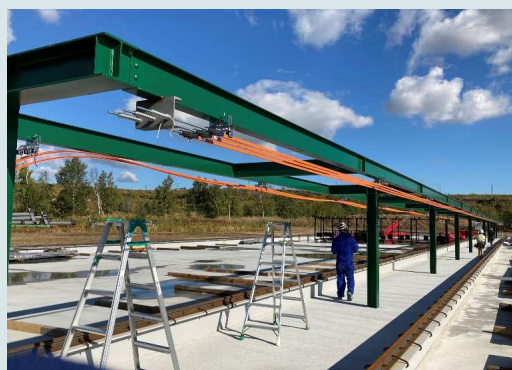
走行絶縁トロリ線敷設工事
