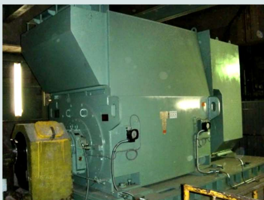
かご型電動機更新 2500KW 6P
