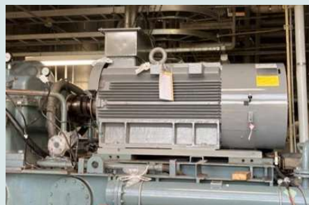
かご型電動機更新 350KW 4P
