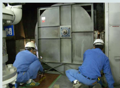
送風機更新・入替作業
