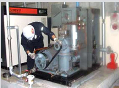
スクリー圧縮機整備
