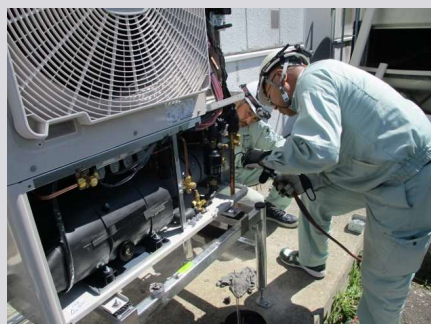
空調機点検・修理作業
