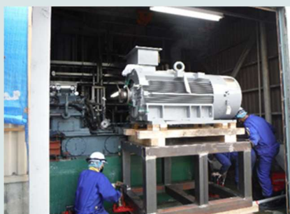
高圧電動機の入替作業
