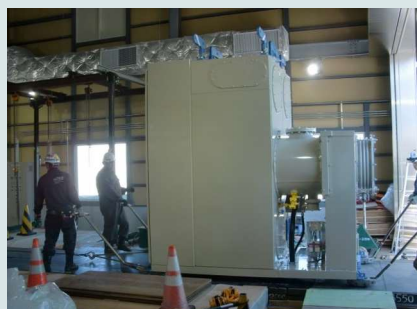
ガス絶縁開閉器搬入作業
