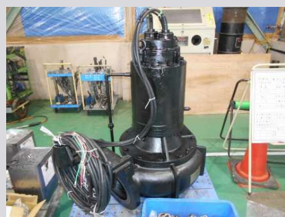
水中汚水ポンプ分解整備
