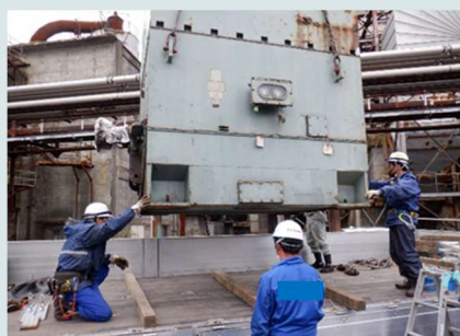
電動機現場搬出入・据付作業
