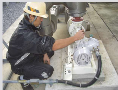
陸上渦巻ポンプ現地整備
