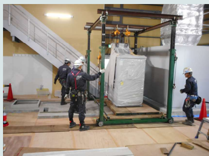
高圧電気機器据付作業
