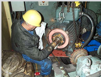
電動機現場軸受交換
