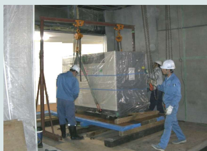
空気圧縮機搬入・据付作業
