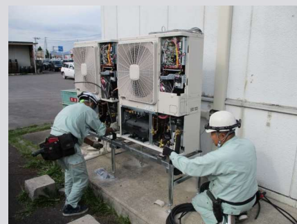
空調機点検・修理作業
